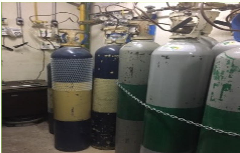
Figura 1 – Baterias de óxido nitroso na Central de Gases Medicinais do Hospital de Transplantes Euryclides de Jesus Zerbini, São Paulo/SP.
